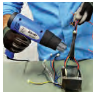
Termoencolhimento em Protetores de Cabos
